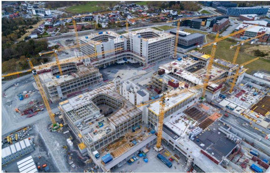
Nye Stavanger universitetssjukehus (Nye SUS)
