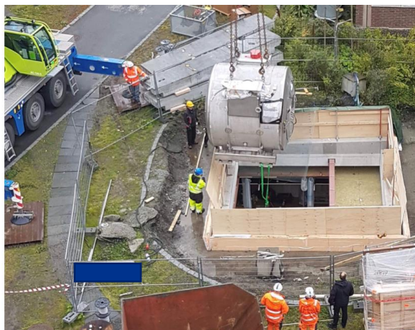
Bilde 9.3 Innlasting av 7 Tesla MR maskin ved St. Olavs hospital HF (Foto Sykehusbygg HF)
