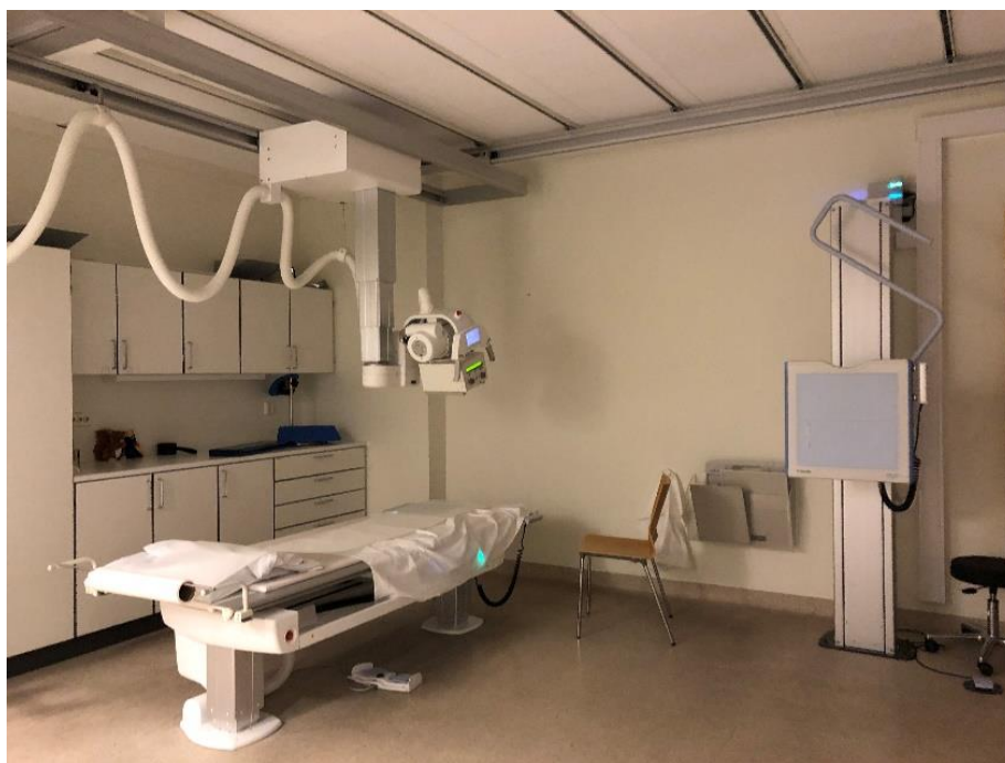
Bilde 9.1 Generell røntgen ved AHUS. Takhengt utstyr med bord og veggbucky. (Foto: Sykehusbygg HF)
