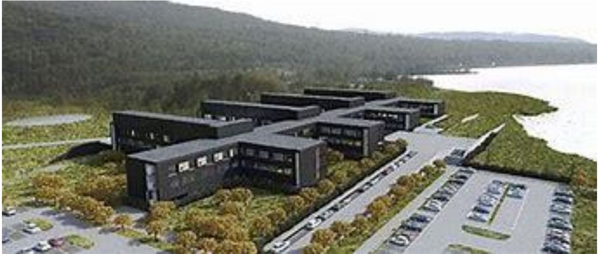
Figur 3 Nye Kirkenes sykehus. Kilde altaposten.no
