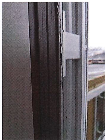
Bilde 3 Vannlekkasje rundt vindu A3-1031, UNN A Fløy. Foto er utklipp fra Interaxo.
