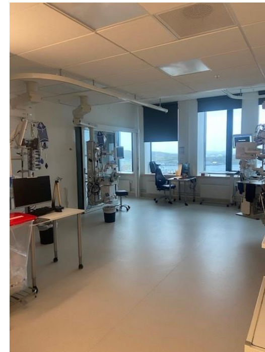
2. Oversikt fra skyvedør inn til sengerom
