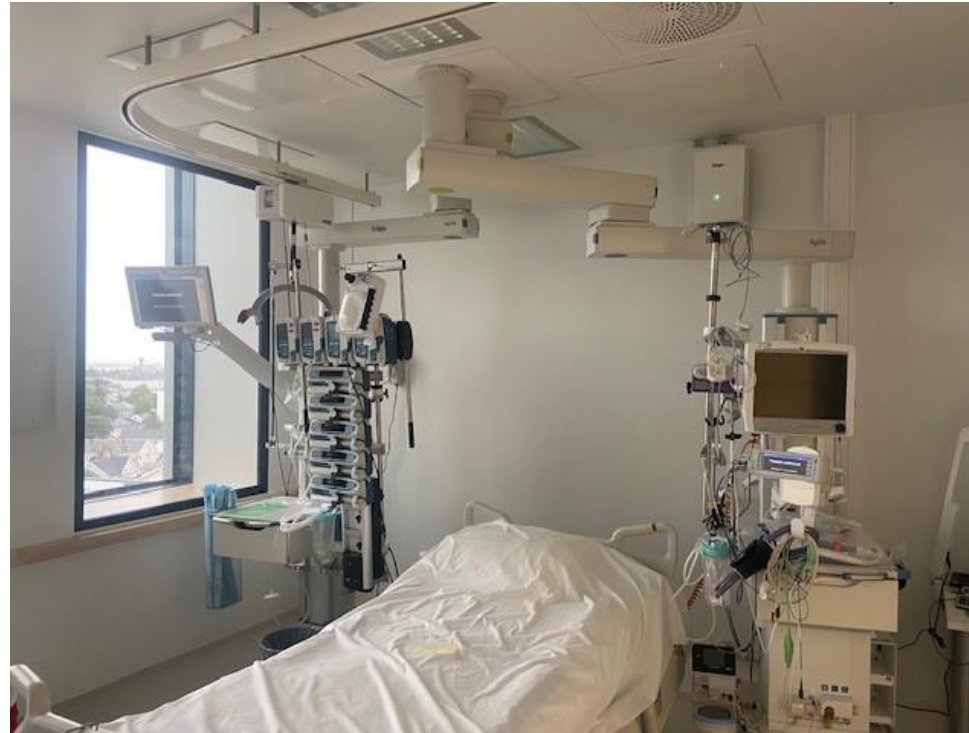
Sengerom i luftsmitteisolat
